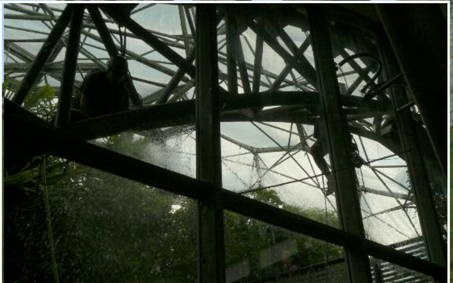
Due addetti al lavoro per la pulizia delle vetrate, hanno l'imbragatura di sicurezza modello alpinismo.
