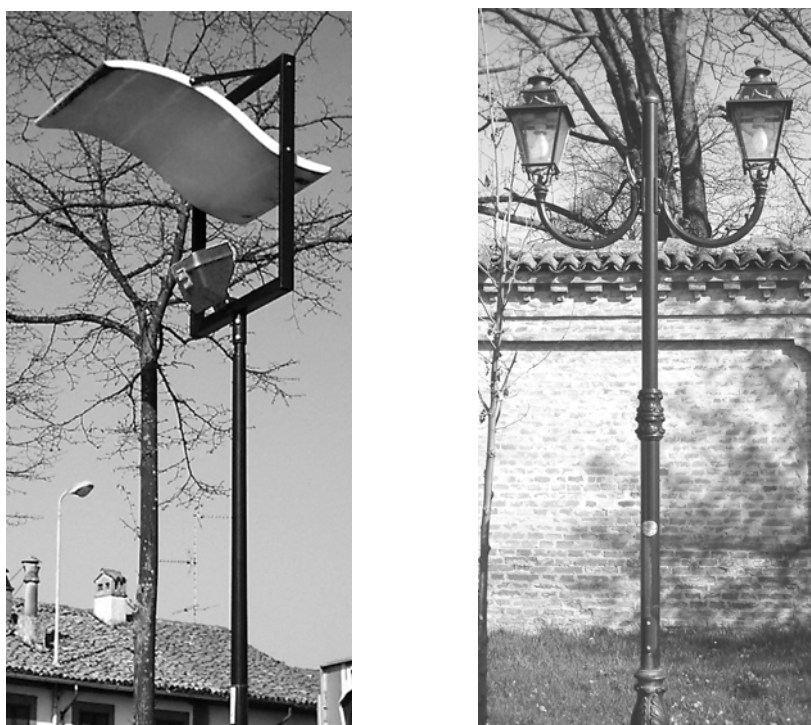
Figura 3-5: corpo illuminante a luce indiretta in piazza Arnaboldi (a sx) e corpo illuminante con due lanterne in piazza della Chiesa (a dx)
