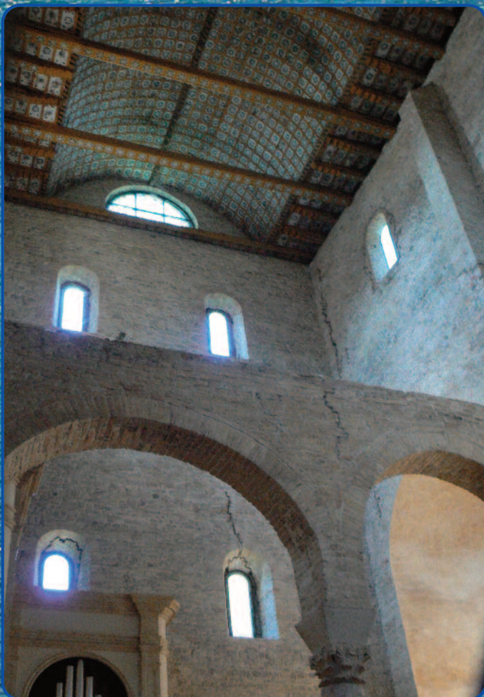
Sull'architrave e sui muri si vedono le crepe causate dal terremoto del 6 maggio 1976
